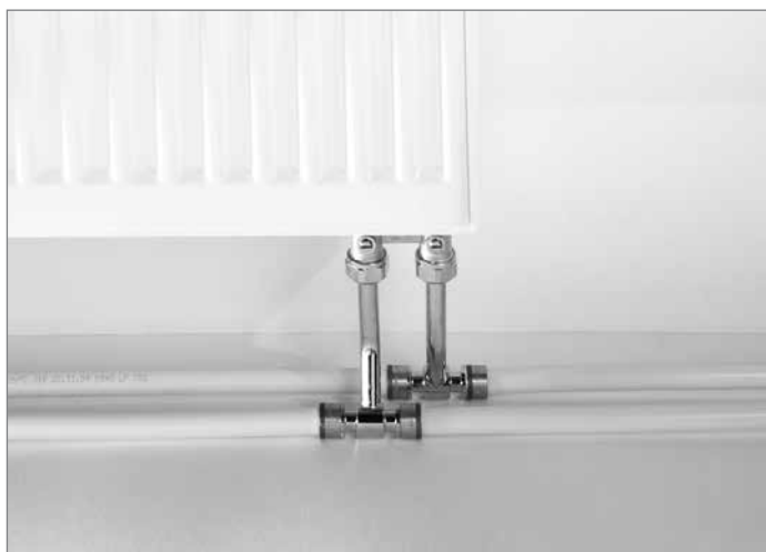
Подключение радиатора с использованием монтажных трубок
